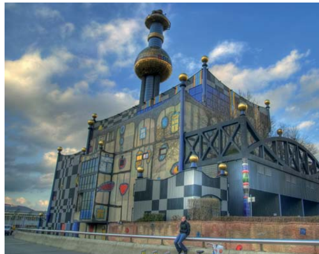
Moderní spalovny nemusí hyzdit své okolí - spalovna ve Vídni
