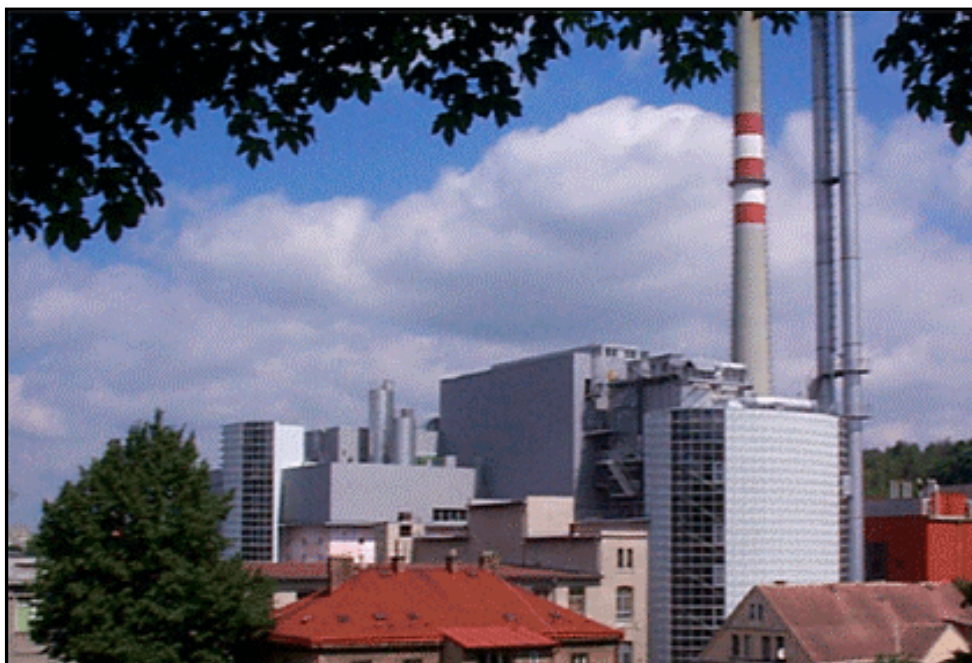
Spalovna Termizo v Liberci (foto: www.odpadjeenergie.cz )
