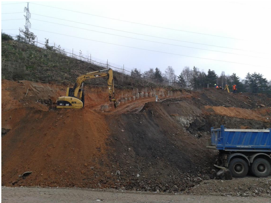
Postup prací na opěrné stěně OZ3
