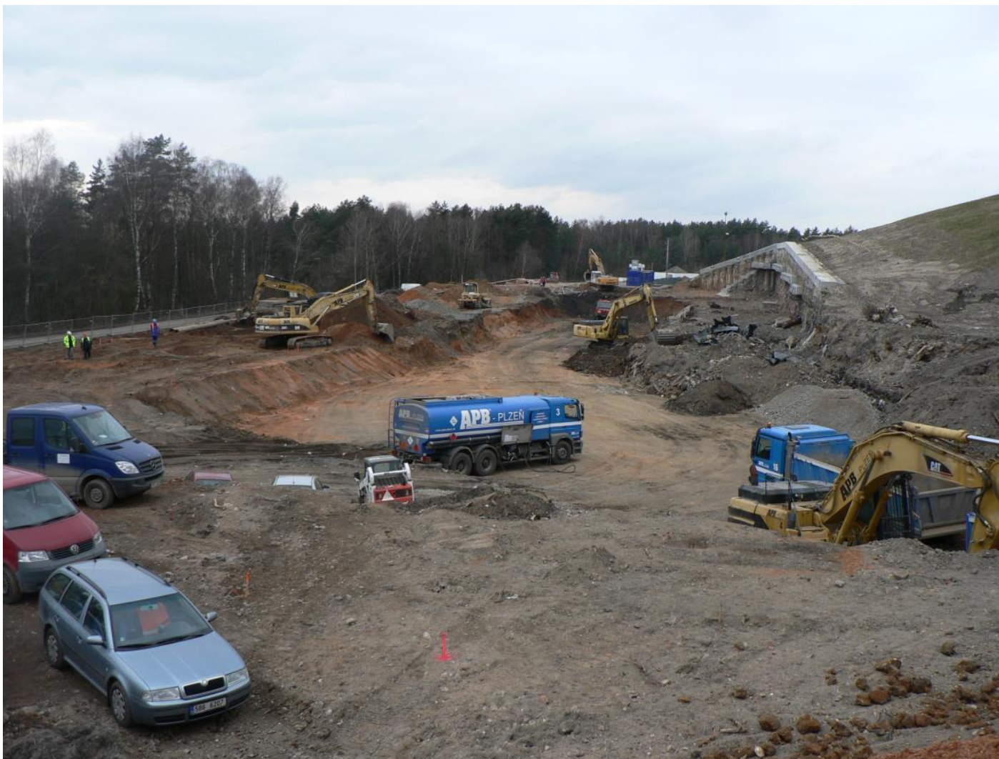
Postup výměny podloží v prostoru staveniště
