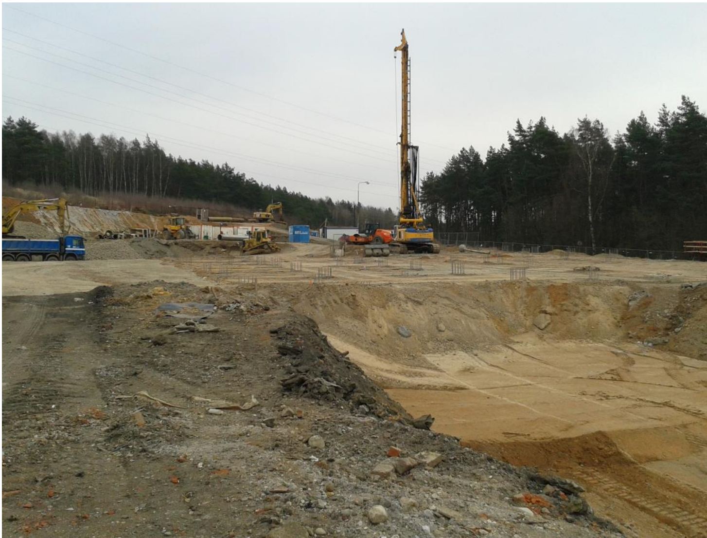
Provádění vrtaných pilot založení HSO
