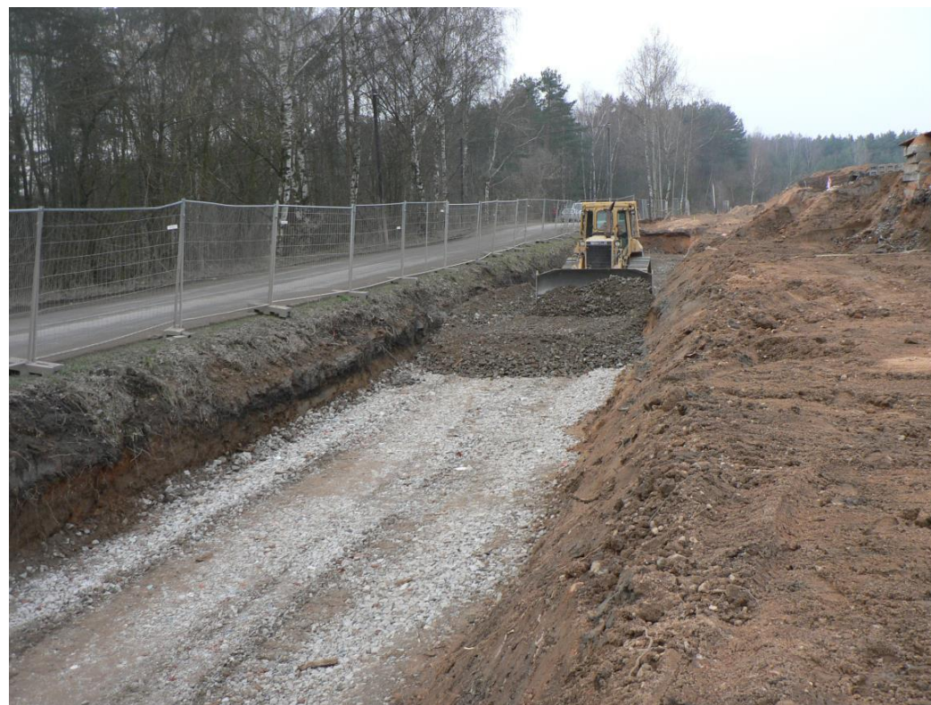
Přípravné práce na provádění opěrné stěny OZ2
