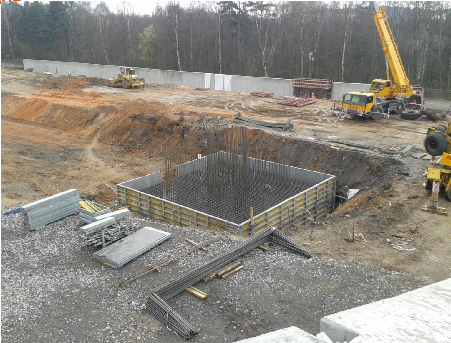
Armování 1. stupně základu pro komín ZEVO
