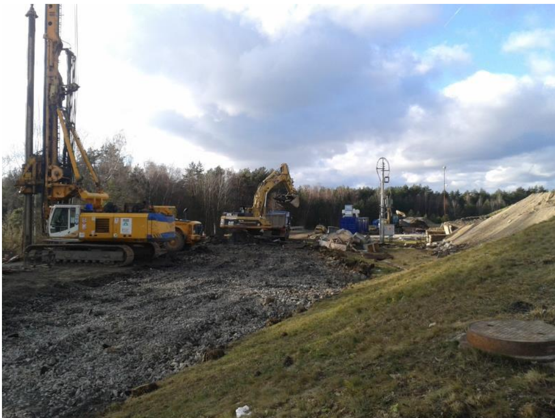
Odstraňování zpevněných ploch na staveništi
