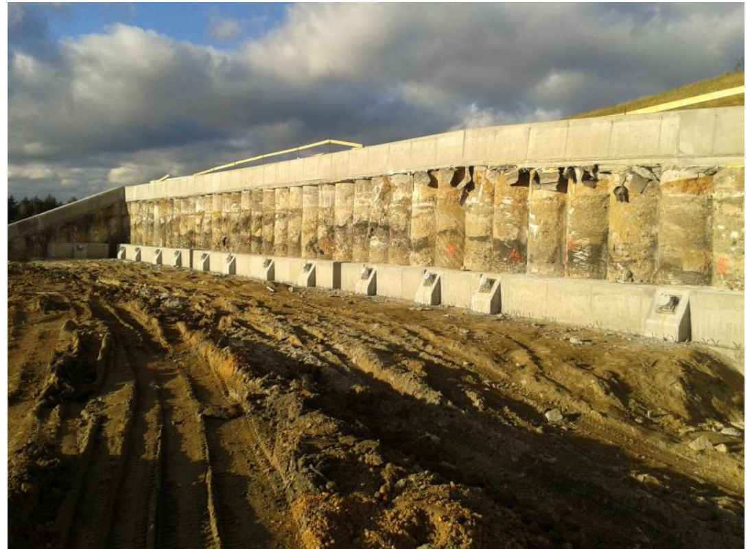
Předeprnuté kotvy na převázkovém trámu opěrné stěny OZ1
