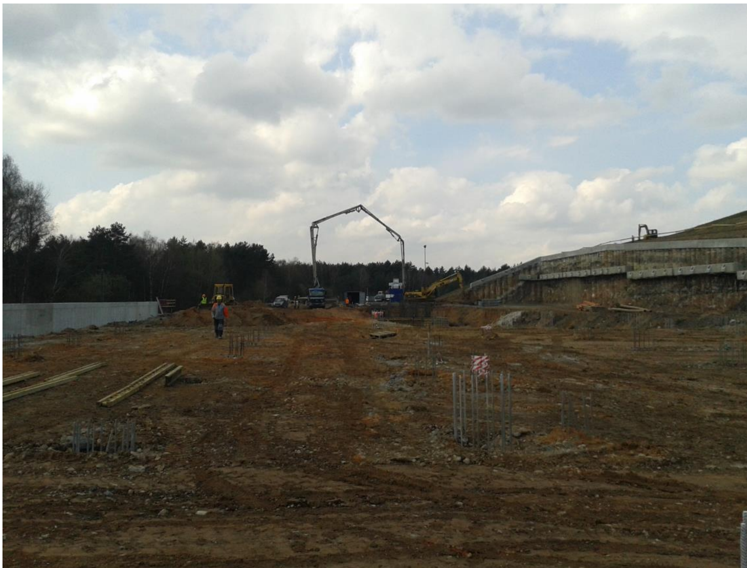
Provádění vrtaných pilot založení HSO
